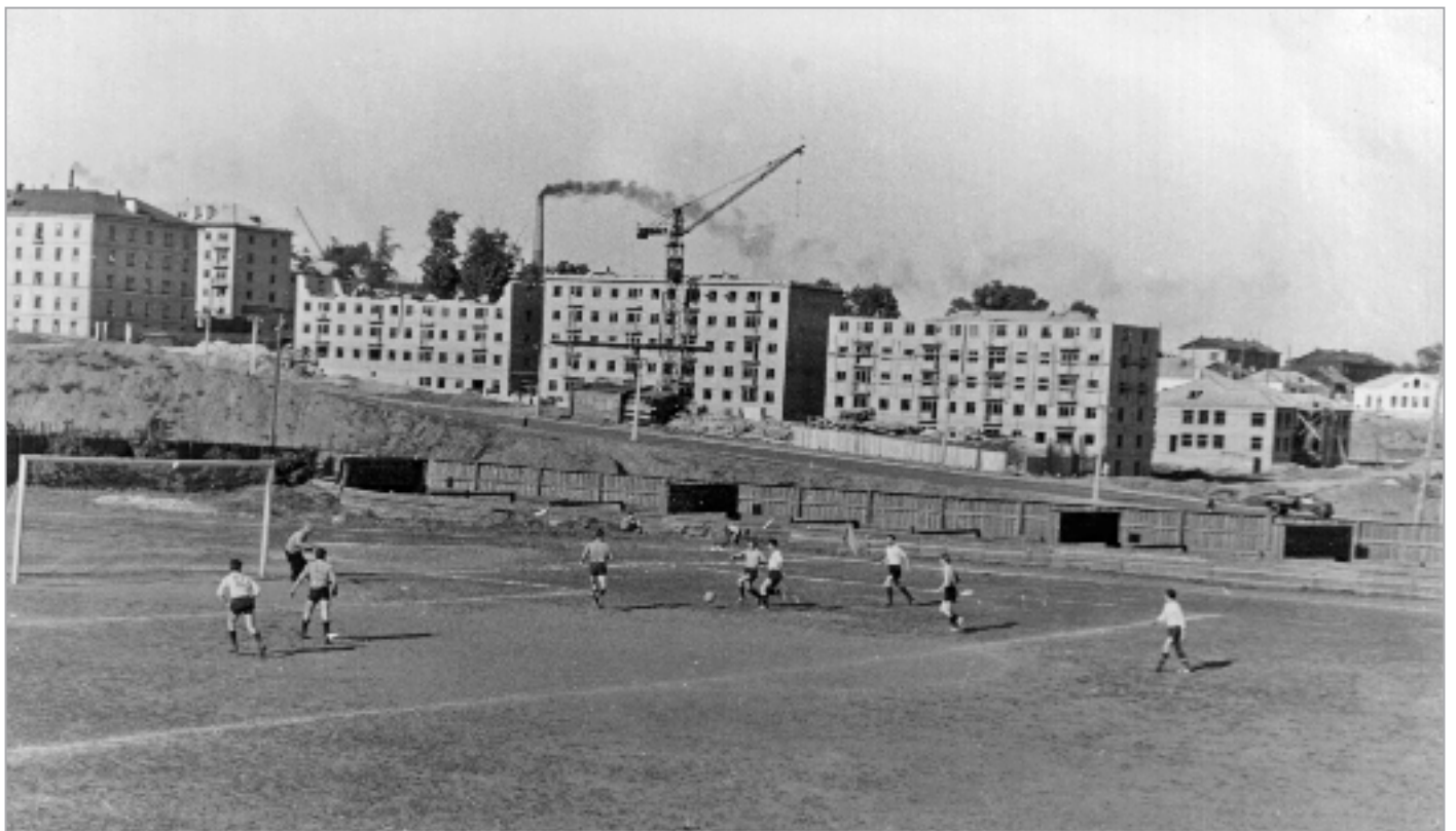
Строительство домов на Октябрьском проспекте от улицы Красноармейской до улицы Пролетарской. 1950-е гг. Автор съемки Б.К. Лысов
