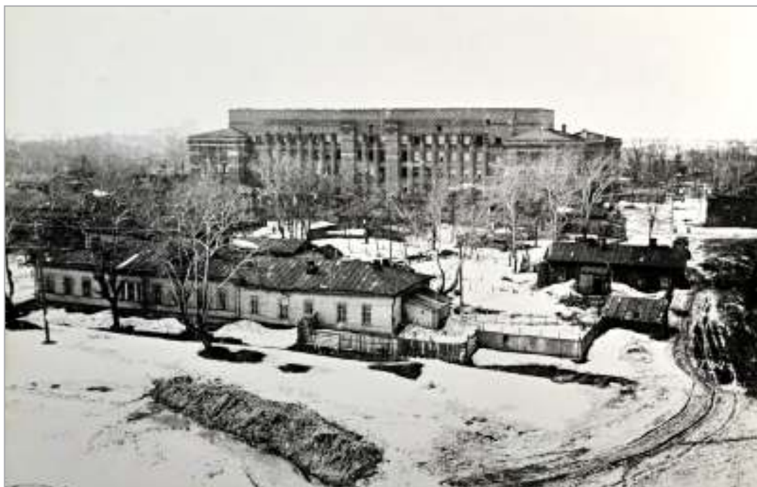
Здание бывшего земского сиротского дома и недостроенный Дом Советов. 1944 г. Автор съемки Л.А. Шишкин
