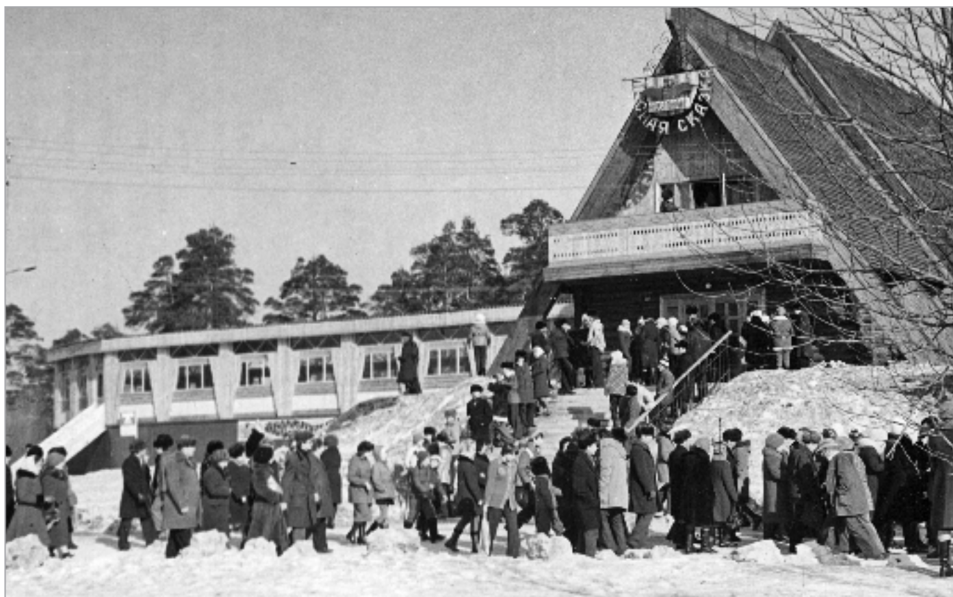
Здание ресторана «Лесная сказка» в Заречном парке. 1980 г. Автор съемки И.А. Цымляков ГАСПИ КО. Ф. П-245. Оп. 16. Д. 220. Л. 1.
